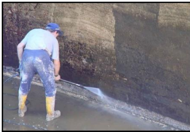
Preparación en muro de contención
