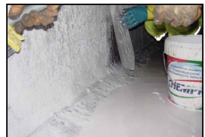
Aplicación en foso de ascensor
