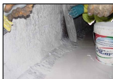
Aplicación en foso de ascensor
