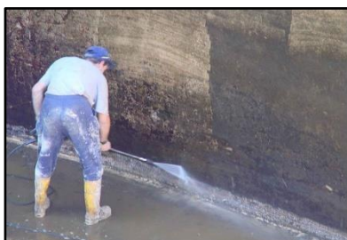
Preparación en muro de contención
