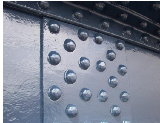
Puente protegido con epoxi
