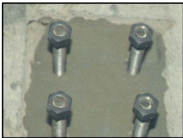
Aplicación en anclajes para pilares metálicos
