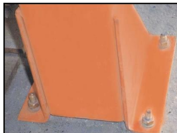
Acabado, tras colocar el pilar en los anclajes
