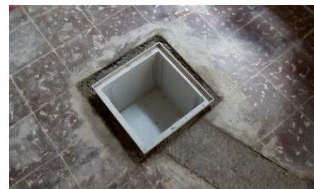
Aplicación en una arqueta
